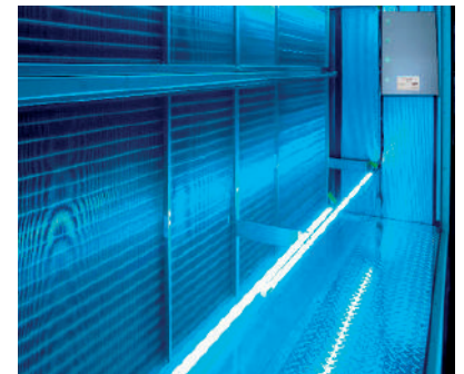
Fig 3. intarSANIT cumple con el Real Decreto 486/2010, de 23 de abril, sobre la protección de la salud y la seguridad de los trabajadores contra los riesgos relacionados con la exposición a radiaciones ópticas artificiales y con la UNE 0048/20 Junio 2020.
