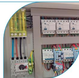
Amplio y accesible, con diferenciales y magnetotérmicos independientes por compresor y ventilador.
