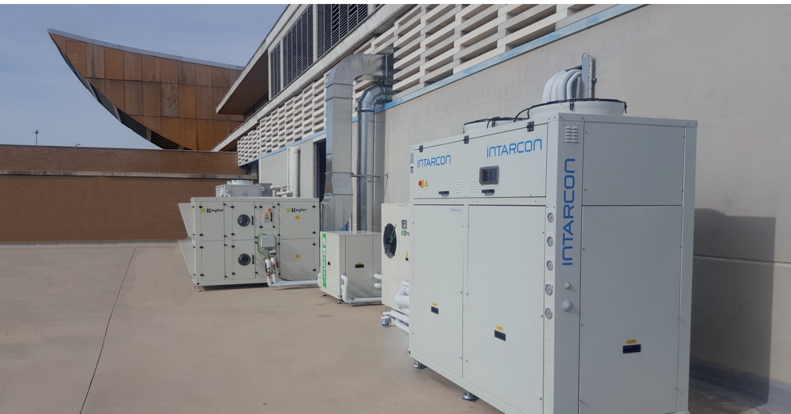
Instalaciones de ensayo ECO2market en el Centro Tecnológico de Lucena del Instituto Andaluz de Tecnología
